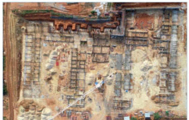
साइट पर छात्रावास ब्लॉक-1 का निर्माण
